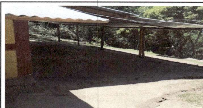
Foto 4: Sustrucción de estructura de soporte de madera, por metal.
