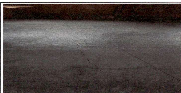
Foto 5: Sustrucción de piso cerámico.
